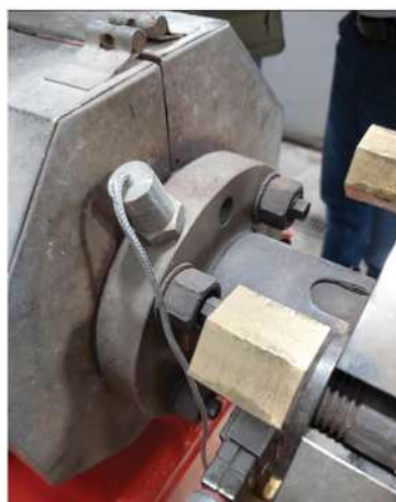
Namestitev novih senzorjev za vibracije na ekstruzijsko linijo.
